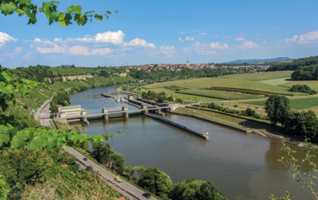
Blick von den Weinbergen auf die Schleuse Poppenweiler.
